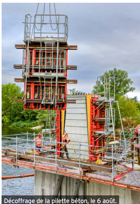
Décoffrage de la pilette béton, le 6 août.
