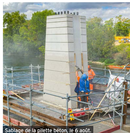
Sablage de la pilette béton, le 6 août.
